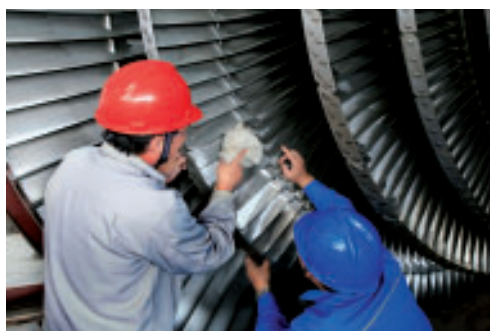
→ (左) 防城港的建築地盤 → (右) 在防城港電廠內清潔渦輪機葉
