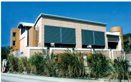
→ (左) 環保大道高效能變電站 → (右) 環保大道變電站天台設有綜合太陽能雨水循環灌溉系統
