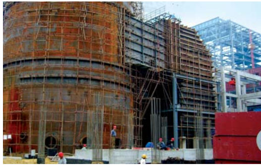
→ (左) 「空中樹林」模型 → (右) 興建中的防城港超臨界燃煤技術電廠
