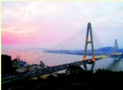
Fuzhou Qingzhou Bridge 福州青洲大橋
