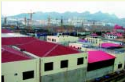
Qingdao Maidaowaste Water Treatment Plant (Extension Facilities) 青島麥島污水處理廠（擴建工程）
