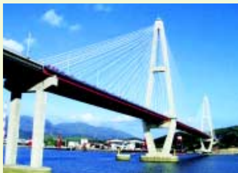
Fuzhou Qingzhou Bridge 福州青洲大橋
