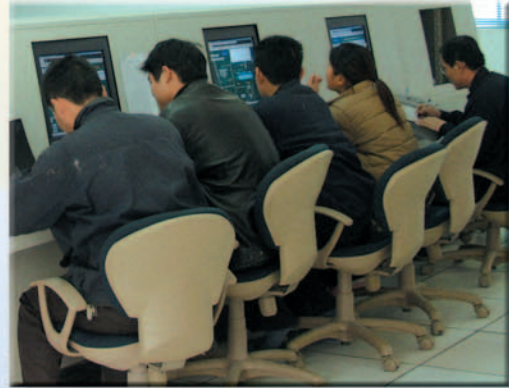
山東聯合王晁中央控制室 Central Control Room of Allied Wangchao
