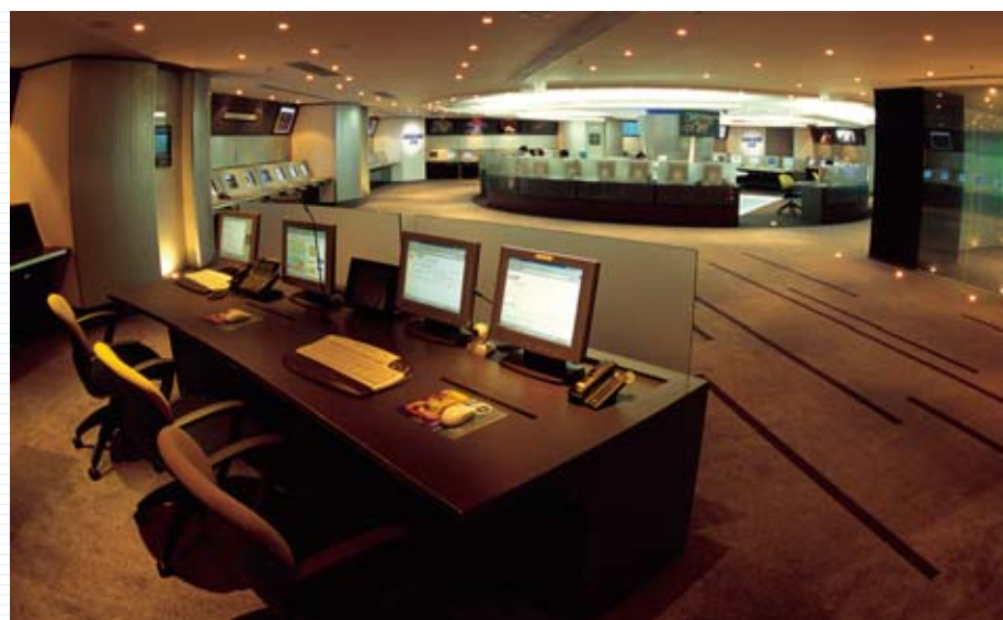
萃鋒設於香港的先進e.Center，全天候24小時自動密切監察電訊盈科及其他主要客戶的網絡運作。
