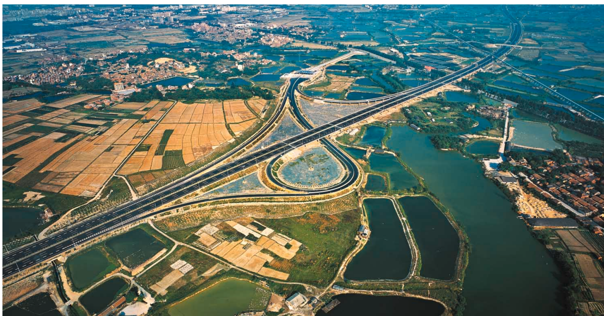
西二環高速公路
