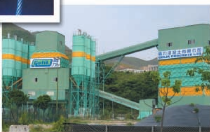
位於香港大嶼山小蠔灣 之混凝土廠
