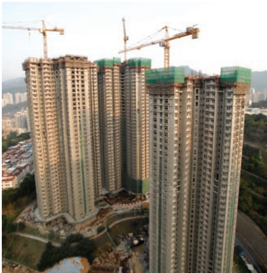
Construction of residential development at Shatin Areas 4C & 38A Phase 3 興建沙田地區第4C及38A區第三期住宅項目
