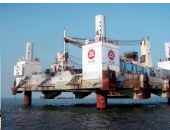
Construction of the man-made island progresses well 人工島的建設由零開始至今已漸見雛型
