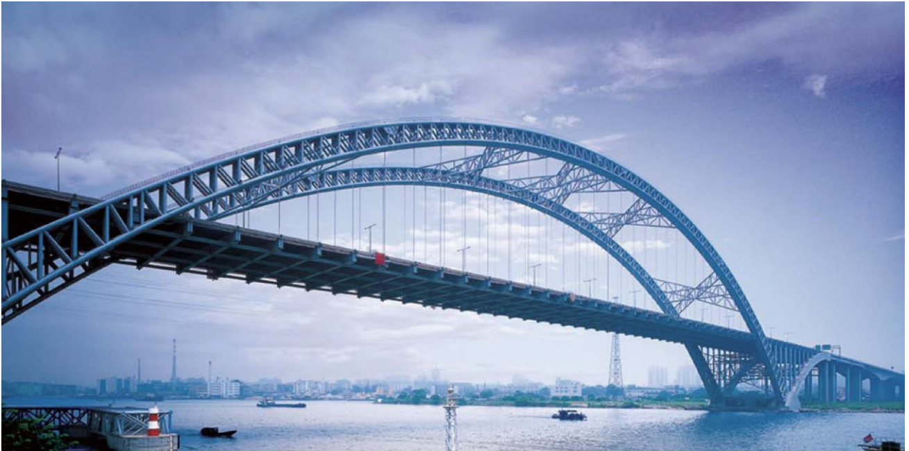
東南西環高速公路丫髻沙橋
