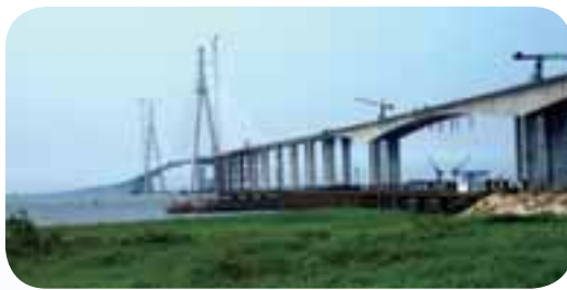
合龍後的蘇通大橋全景
