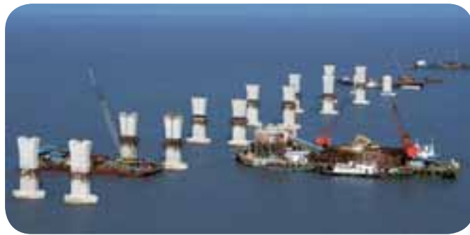
墩柱預製安裝
