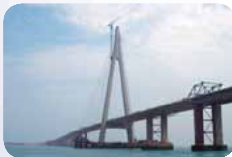
合龍後的杭州灣大橋南航道橋
