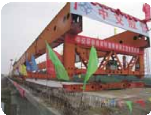
武合鐵路紅安梁場圓滿完成制架箱梁施工
