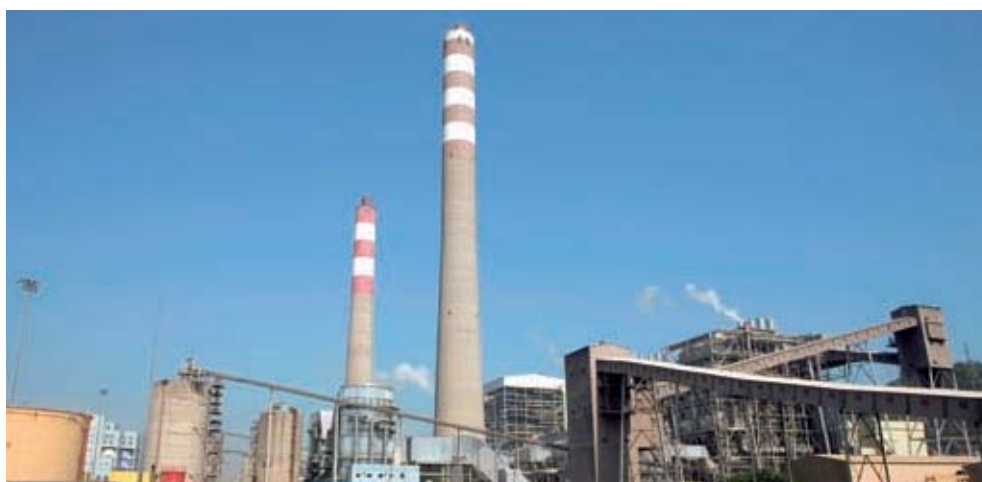
珠海發電廠的延伸部分 — 金灣電廠一期項目於二零零七年二月投產，並提供溢利貢獻。
