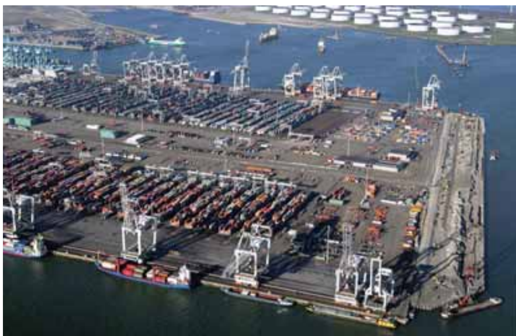
●鹿特丹河口碼頭前端現正進行駁船碼頭興建工程。
