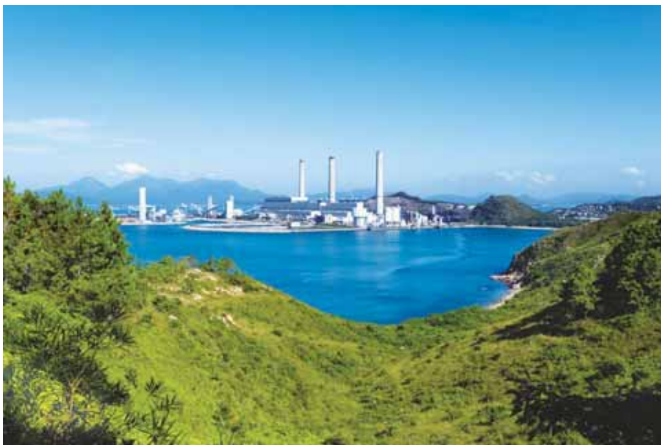
● 港燈南丫發電廠擴建部分的發電機組採用天然氣為主要燃料，對保護環境有正面作用。
