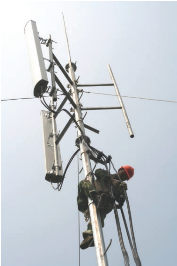
移動機站建設
