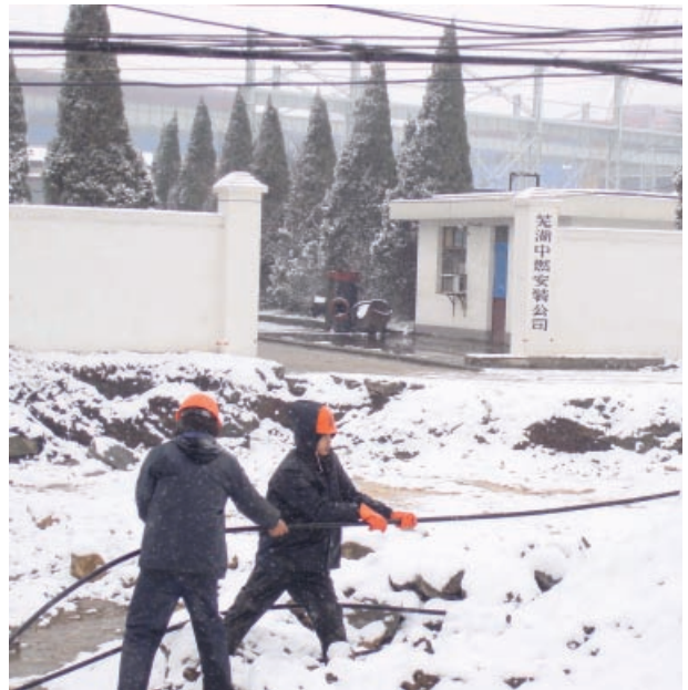
管線工程施工
