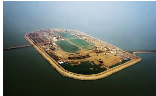
冀東油田南堡1號人工島工程
