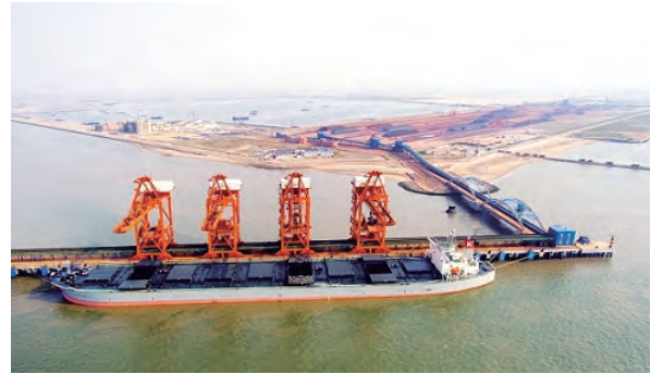
曹妃甸礦石碼頭一期工程
