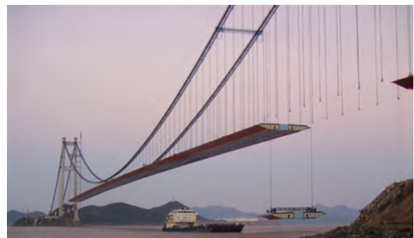
西侯門跨海大橋
