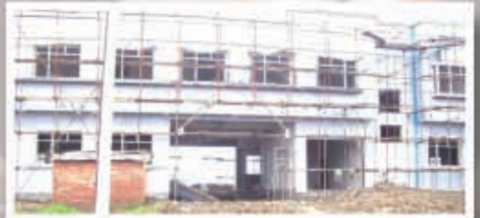
C8-Temporary Office 臨時辦公室
