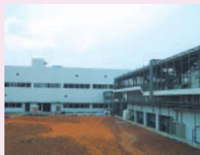
動力站(建築面積19,563 m 2 ) Utility Station (Gross Area 19,563 m 2 )
