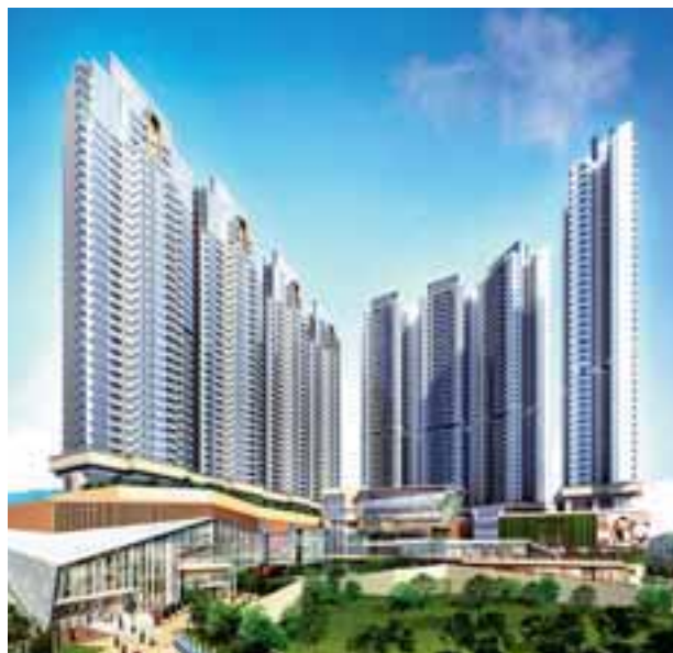
興建中的 YOHO Town 第二期，秉承第一期的規劃，質素更勝一籌。
