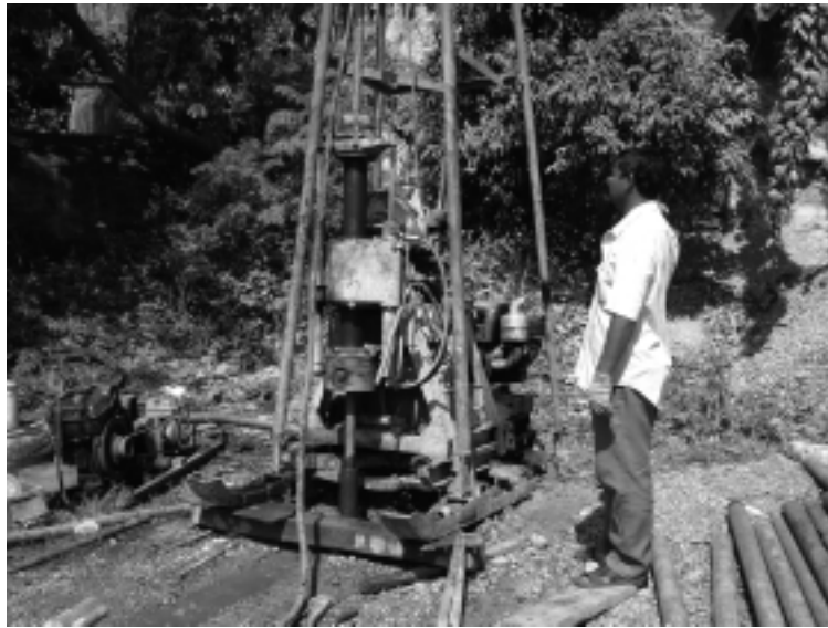
圖12：正在BH-1號鑽孔(南山)處進行鑽探工作
