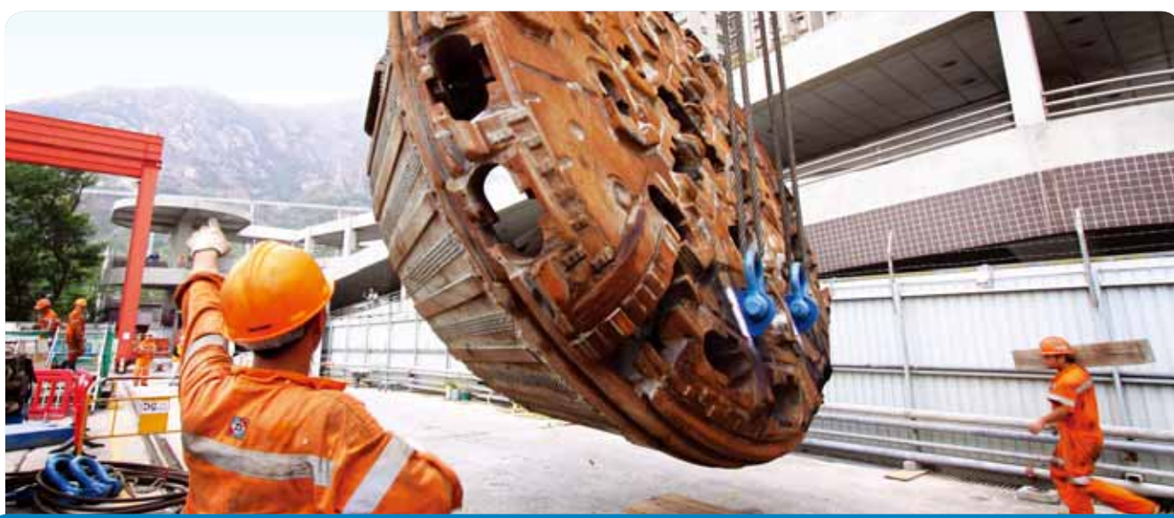
在青山發電廠取出隧道鑽鑿機的切割頭
