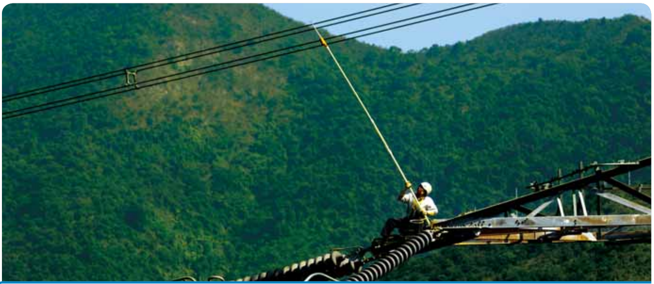
天線技術員在400千伏架空線工作
