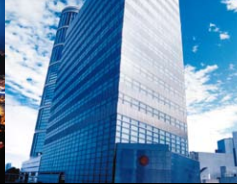
添馬變電站是去年完成的多個主要輸電項目之一。
