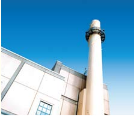
TransAlta Cogeneration, L.P.持有加拿大六間發電廠的權益。
