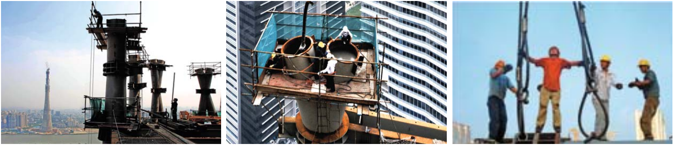
廣州國際金融中心施工
