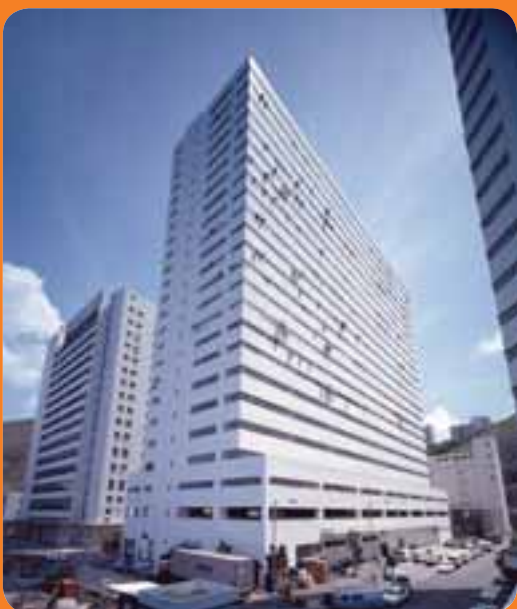
香港鴨脷洲港灣工貿中心
