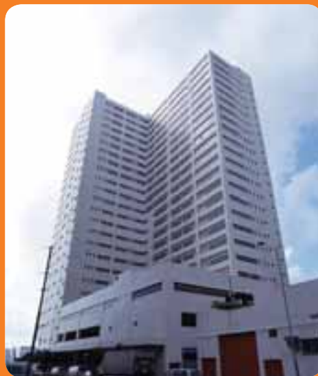
香港鴨脷洲海灣工貿中心
