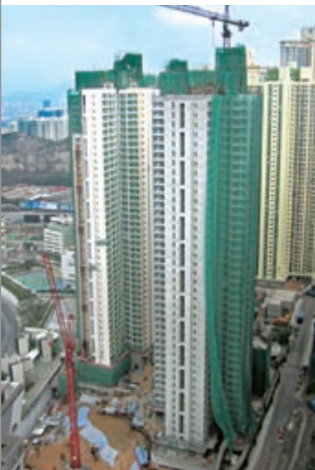
東區海底隧道第四期建築工程
