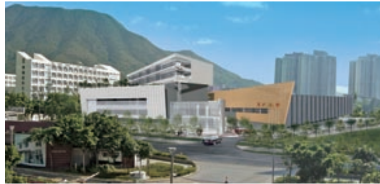
東涌體育館綜合大樓
