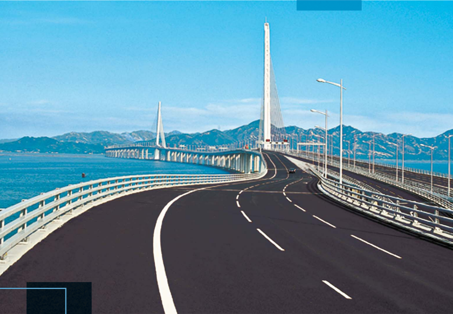
深圳灣公路大橋設計項目
