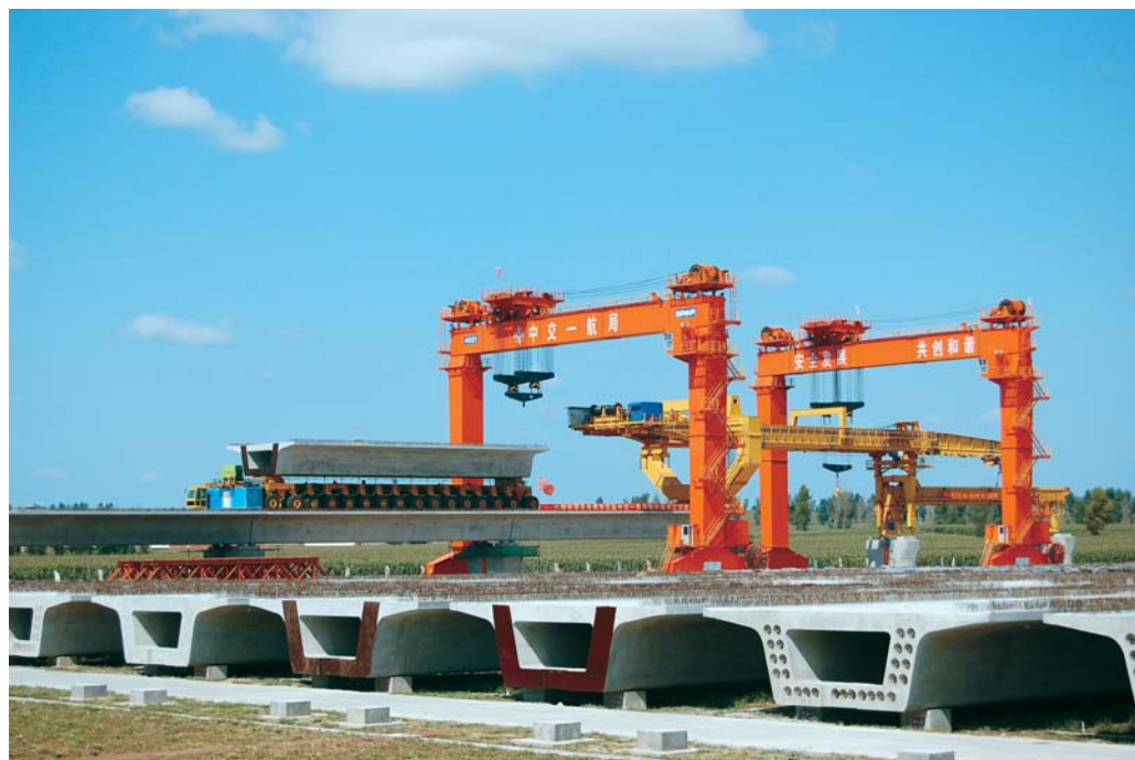
哈大鐵路客運專線架樑施工現場
