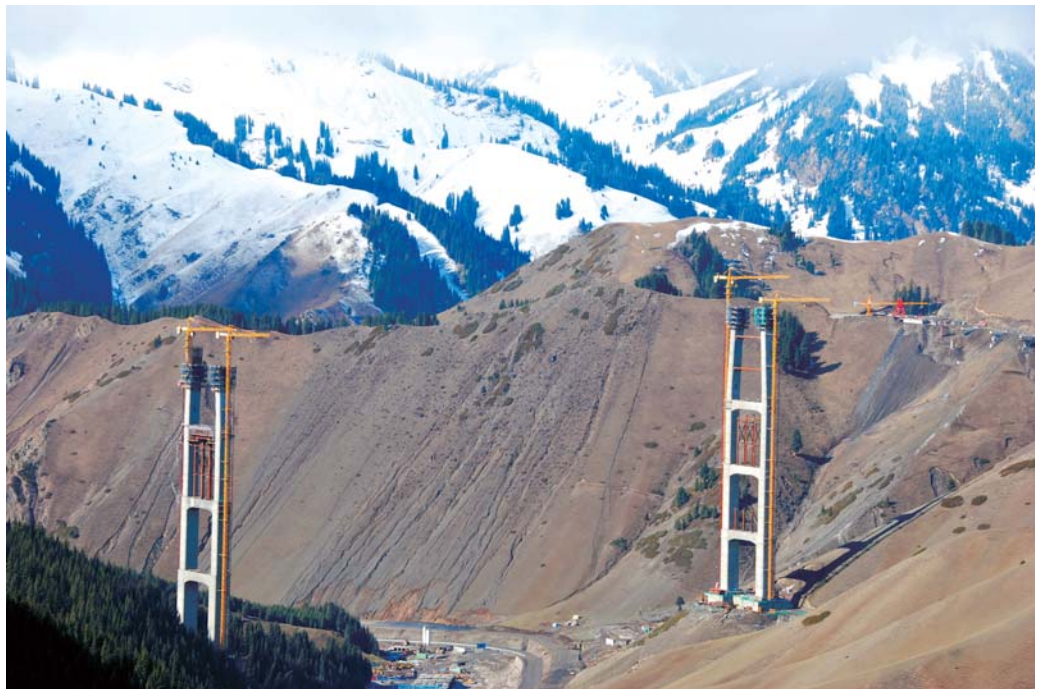
新疆果子溝特大橋，是國內第一座高塔鋼桁樑公路斜拉橋
