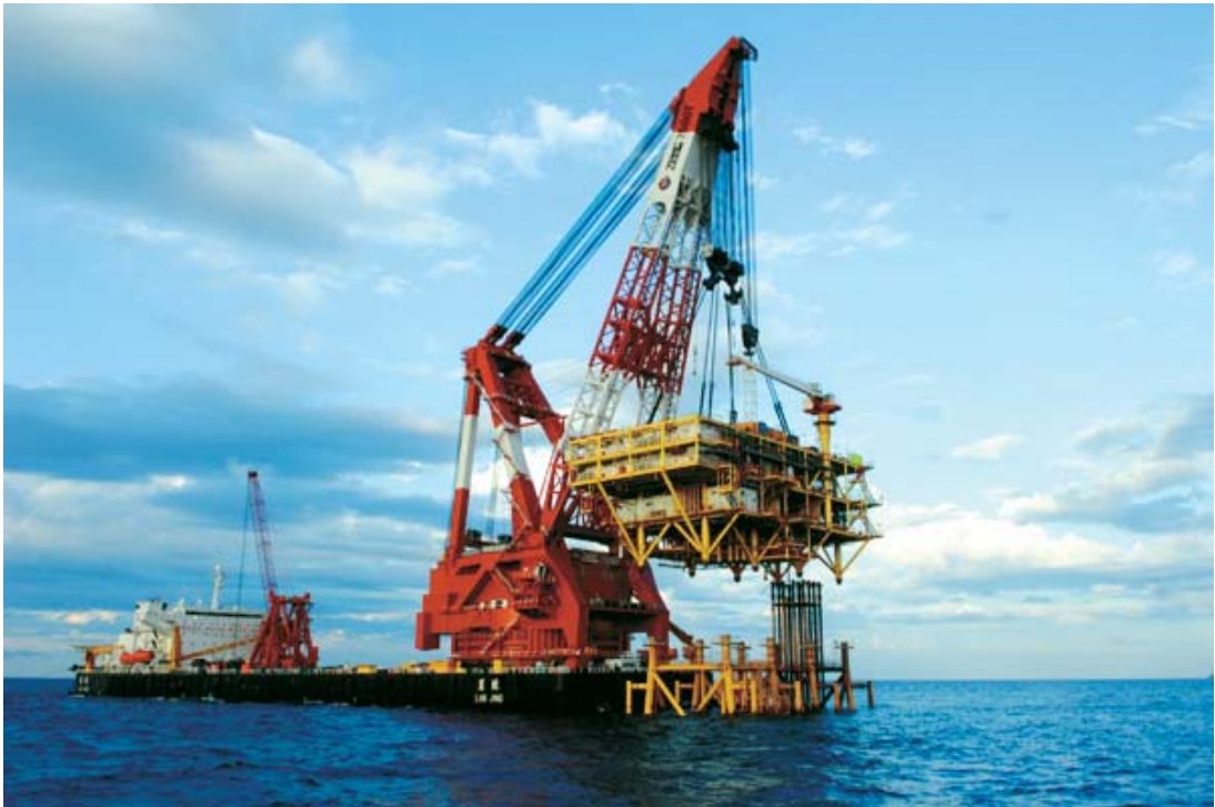
振華港機自主研製的7,500噸全回轉起重船「藍鯨」號，交付使用後圓滿完成第一吊
