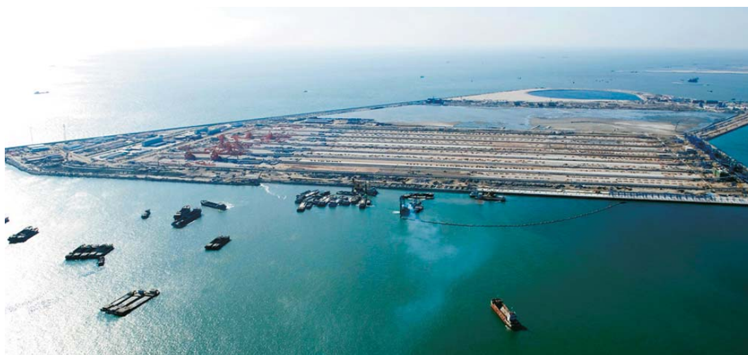
曹妃甸煤碼頭起步工程港池航道疏浚竣工，完成疏浚量1,740萬立方米
