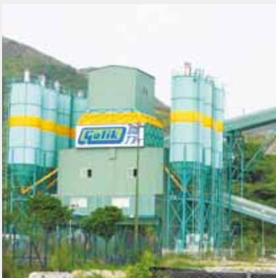
位於香港大嶼山小蠔灣之混凝土廠
