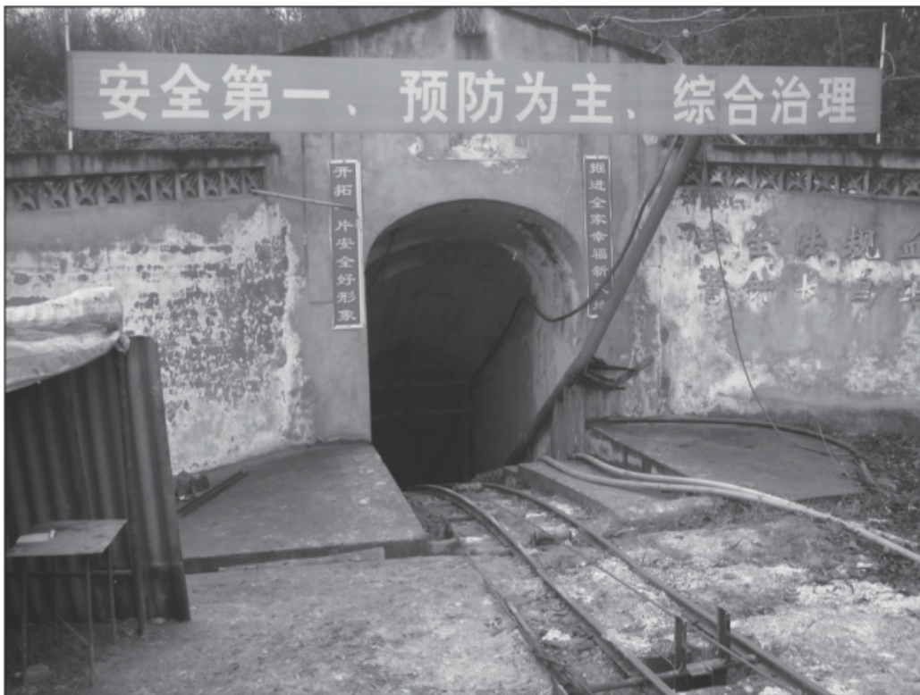
礦石提升斜井入口
