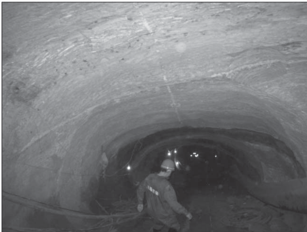
3號斜井(以掘進機開挖)
