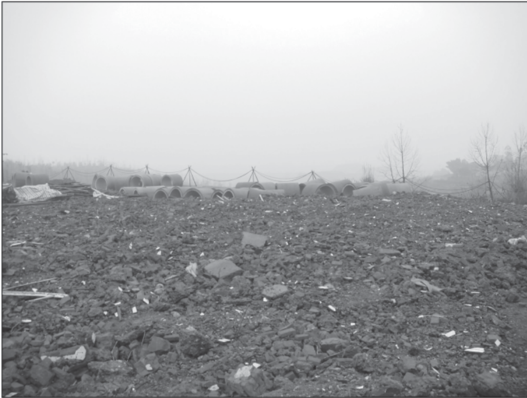
地面設施區 (已拆毀舊廠房及樓宇)
