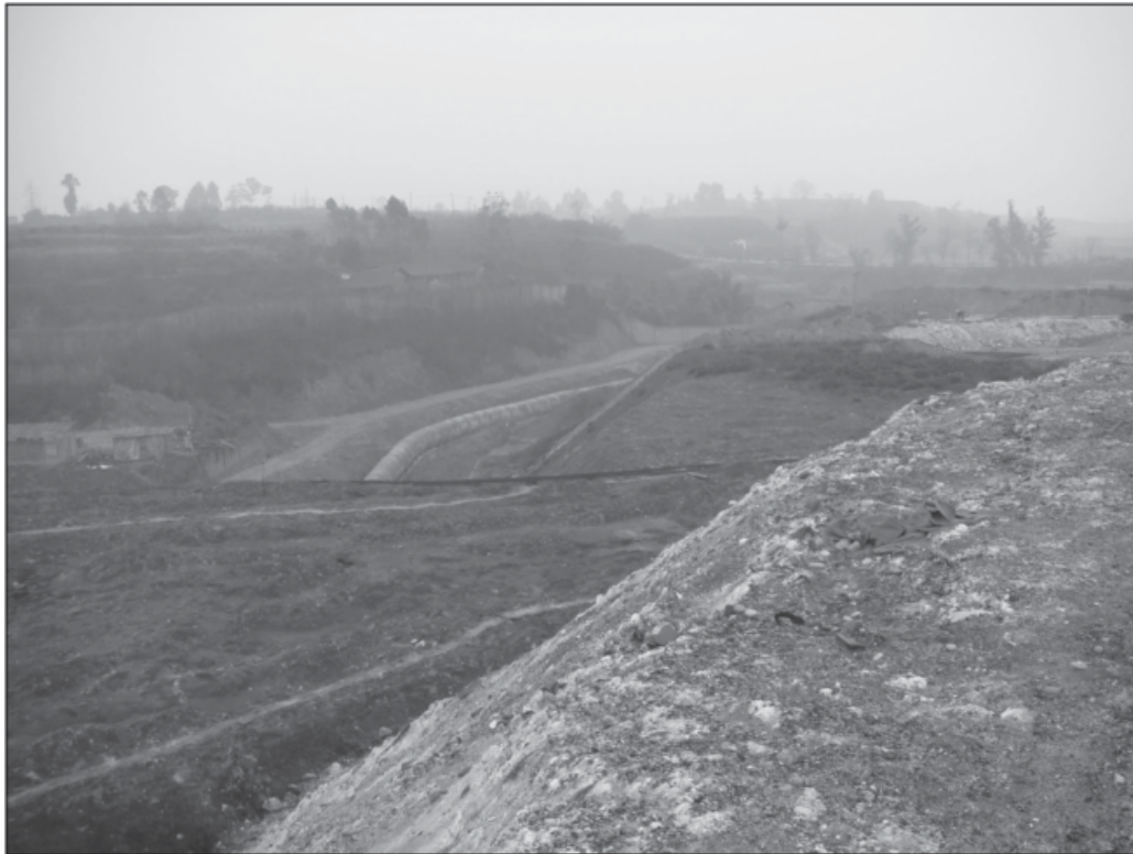
場地籌備區 山谷導流管建設
