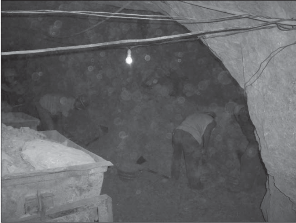
手工裝載礦石巷道掘進面作業
