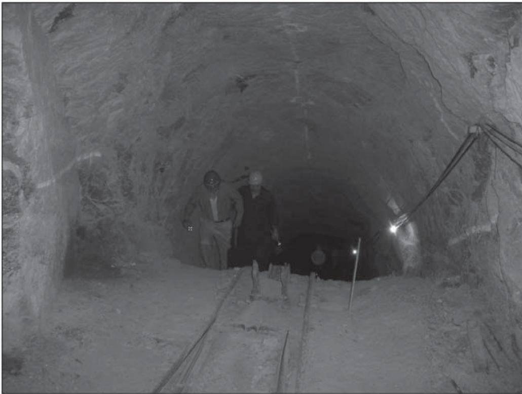
井筒／通往溶區的在建起吊巷道
