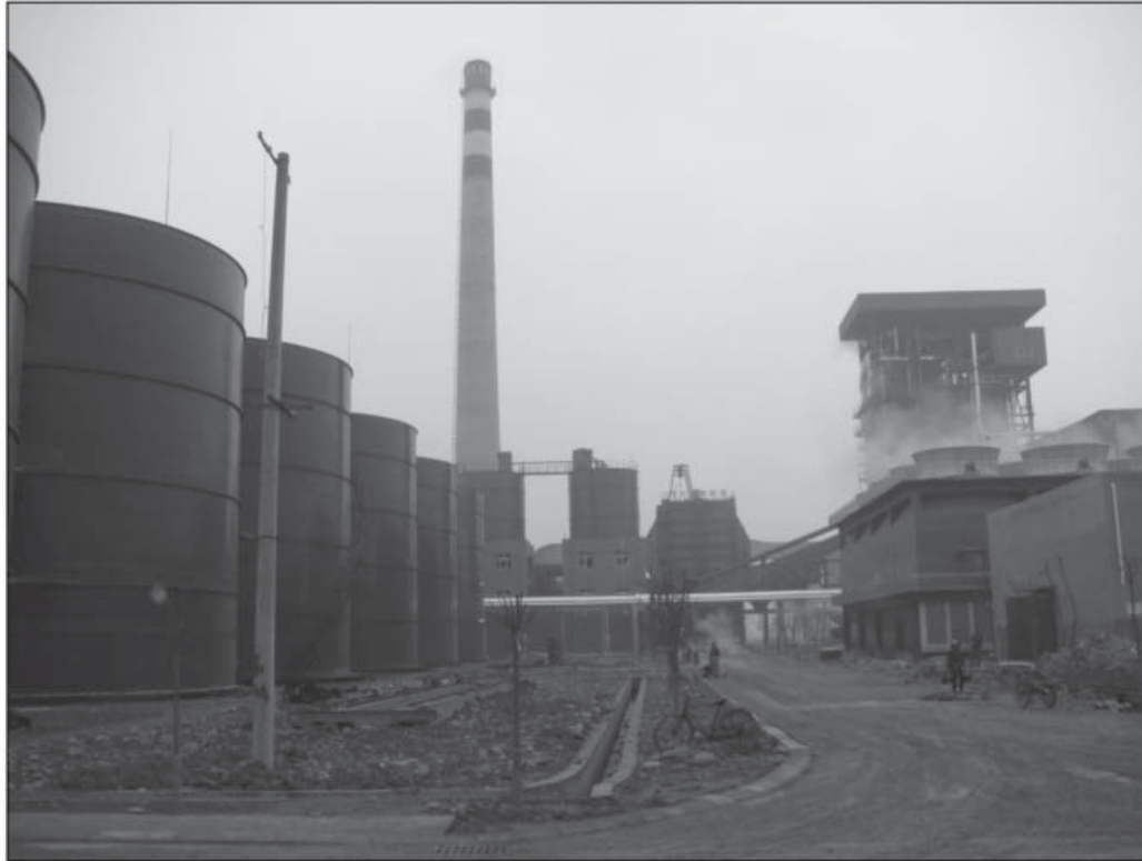
電廠／水處理設施
