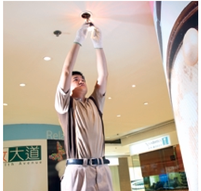
安裝節能照明裝置
