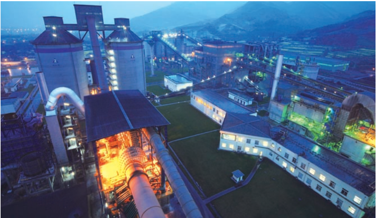
四川都江堰廠房
