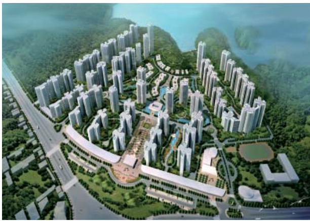
廣州獅嶺項目是毗鄰水庫的大型住宅發展項目。
