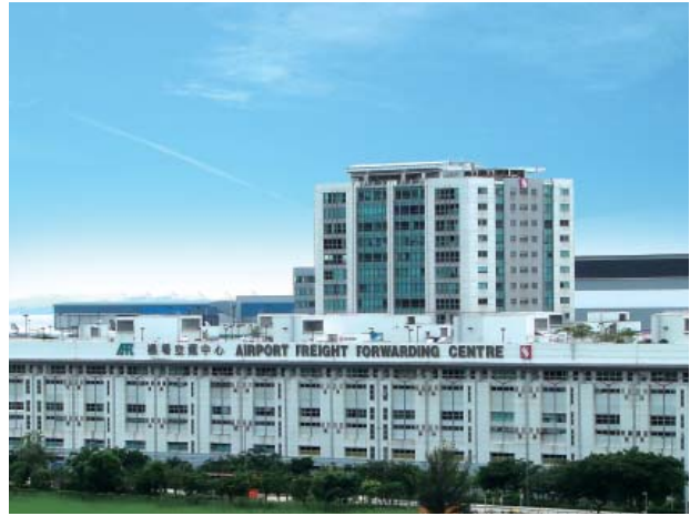
機場空運中心保持穩定的收入及營運溢利。
