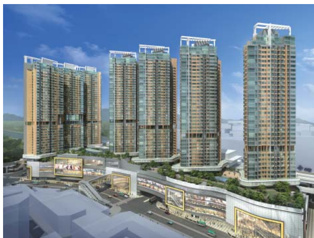
西鐵屯門站項目坐落交通樞紐，擁有開揚景致。
