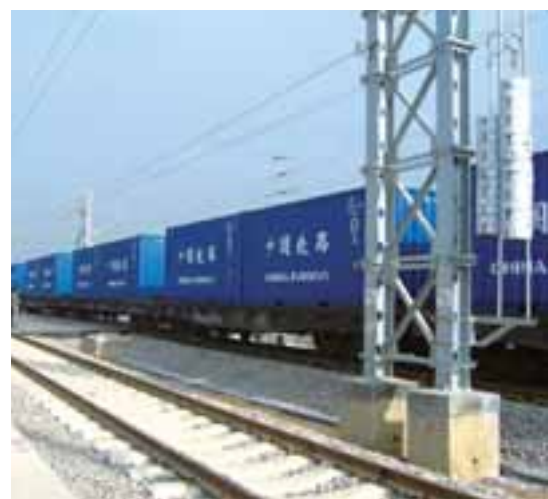
昆明鐵路集裝箱物流中心
