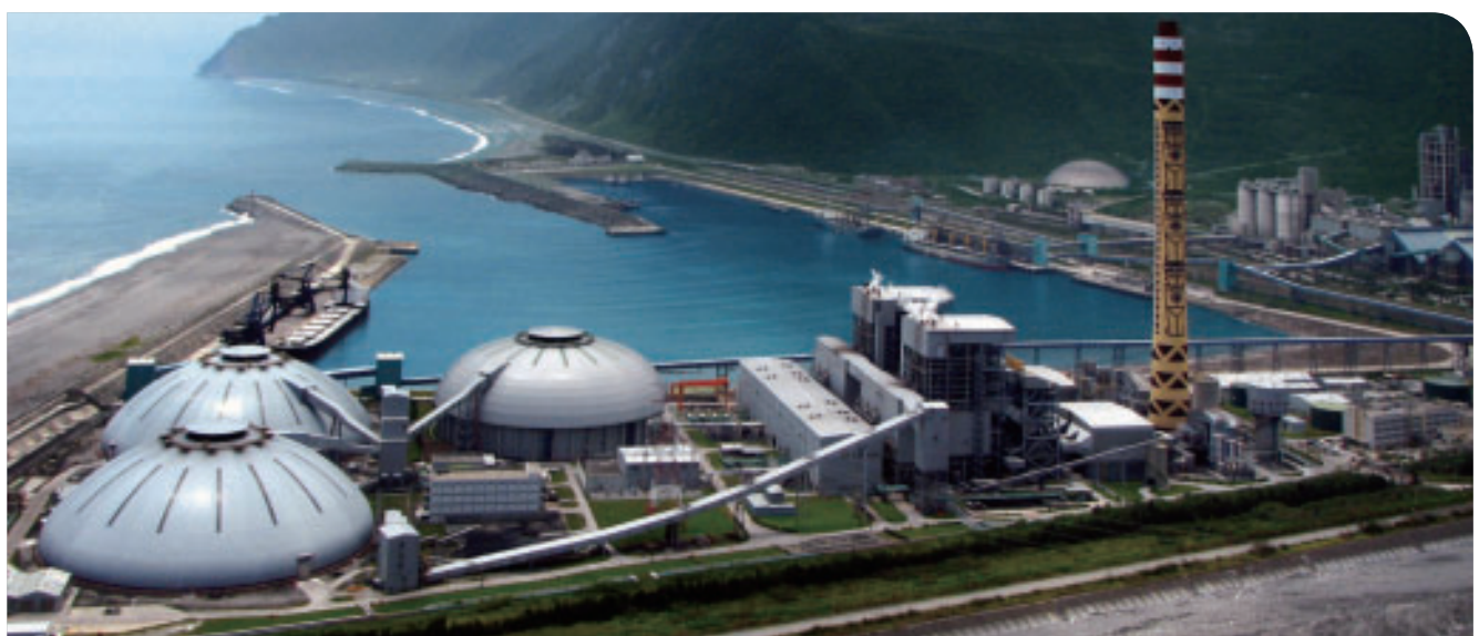
○ 和平電廠 — 已修復的圓頂煤倉
