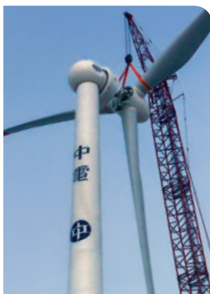
中電於中國擁有的首個全資風場——乾安風場——正在安裝風機葉片
