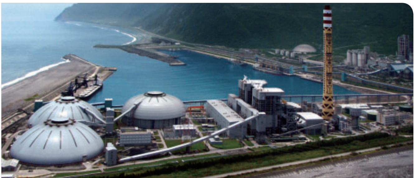
和平電廠 — 已修復的圓頂煤倉
