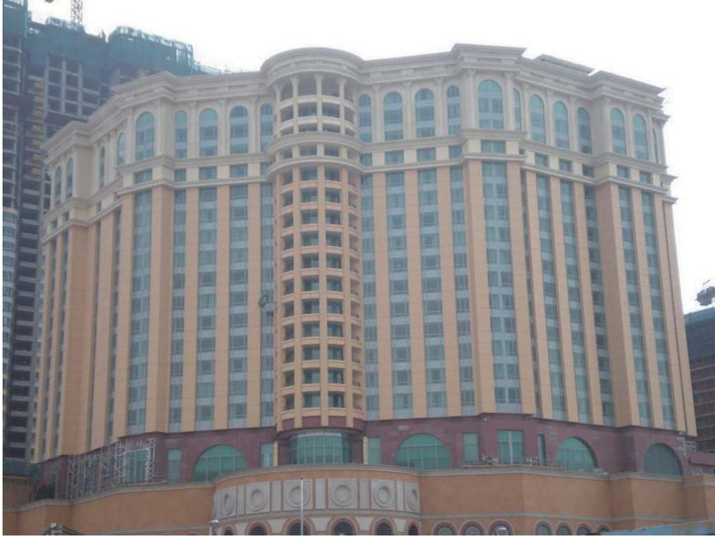
澳門四季酒店位於澳門。本公司透過其全資擁有的力進工程（遠鋁）澳門有限公司承接此項目。本公司於二零零七年對此項目開始施工，而項目已於二零零八年竣工。此項目所涉及的幕牆總面積為約36,000平方米。此項目的建築物外牆產品範圍廣泛，包括與玻璃纖維強化混凝土面板系統連接的混合幕牆系統。
