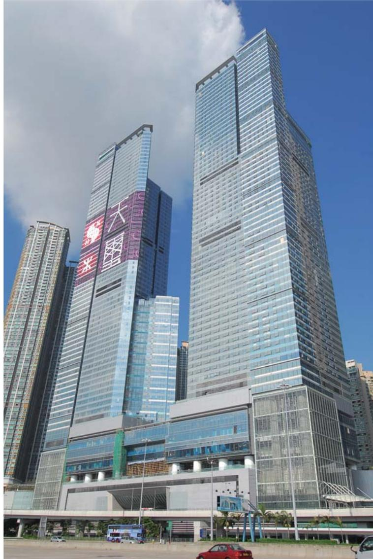
天璽II位於香港九龍。本公司透過其全資擁有的遠東鋁質工程有限公司承接此項目。本公司於二零零五年對此項目開始施工，而項目已於二零零八年竣工。此項目所涉及的幕牆總面積為約50,000平方米。此項目為住宅／酒店混合使用大廈，採用成套的幕牆系統作為外牆設計。
