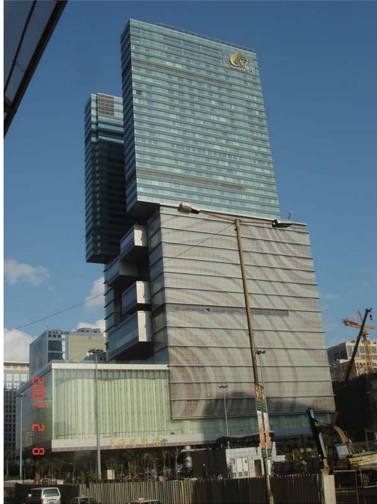
星際酒店位於澳門。本公司透過其全資擁有的力進工程（遠鋁）澳門有限公司承接此項目。本公司於二零零五年對此項目開始施工，而項目已於二零零六年竣工。此項目所涉及的幕牆總面積為約65,000平方米。此項目別具一格的技術特色包括高跨度的裙樓玻璃牆，將陶瓷燒熔的模式與外牆發光系統融為一體。
