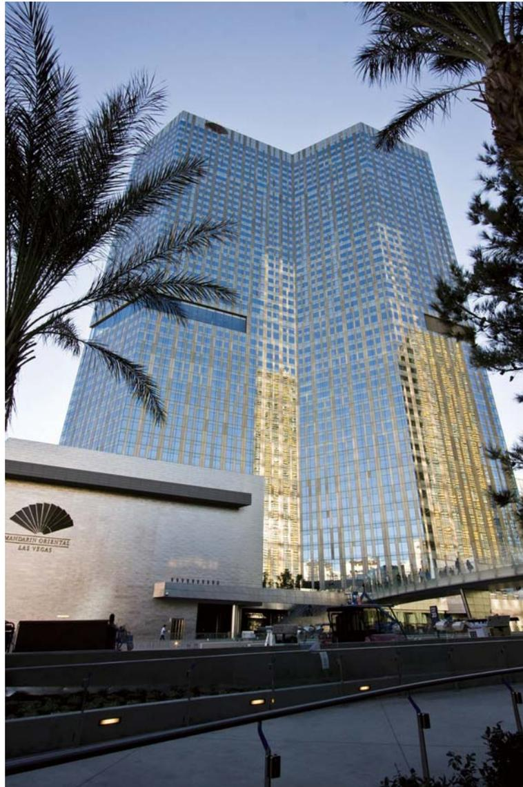
文華東方酒店位於美國拉斯維加斯。此項目與Veer Towers項目一併授予本公司。本公司透過其全資擁有的Far East Aluminium Works (U.S.) Corporation承接此項目。本公司於二零零六年對此項目開始施工，並預期於二零一零年竣工。所涉及的幕牆總面積為約37,000平方米。此項目所用的幕牆單位由玻璃及鋁質面板組成，每塊玻璃面板均屬於具有遮蔽功能的陶瓷燒熔款式，在控制太陽光增熱及照射的同時，允許大量的日光可透進建築物內。
