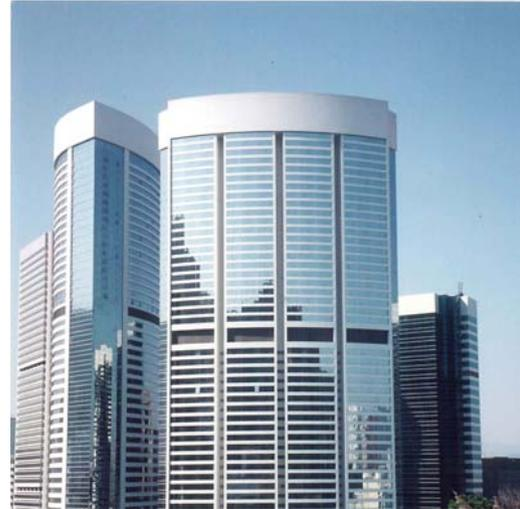
窗牆與安裝在建築物板邊緣的幕牆不同，窗牆一般是安裝在分隔建築物的磚與磚之間。
