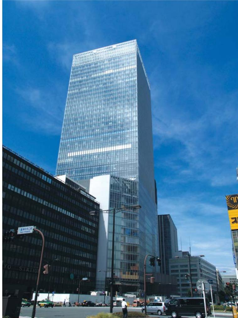
東京站八重洲項目北座位於日本東京。本公司透過其全資擁有的遠東鋁質工程有限公司承接此項目。本公司於二零零五年對此項目開始施工，而該項目已於二零零七年竣工。此項目所涉及的幕牆總面積為約27,000平方米。本公司承接此項目建築物外牆產品的供應及預製，並由總承辦商負責安裝。此項目使用了一定範圍的建築物外牆產品，包括附設開敞式窗戶的幕牆、鋁質鍍層、百葉窗及金屬網罩。
