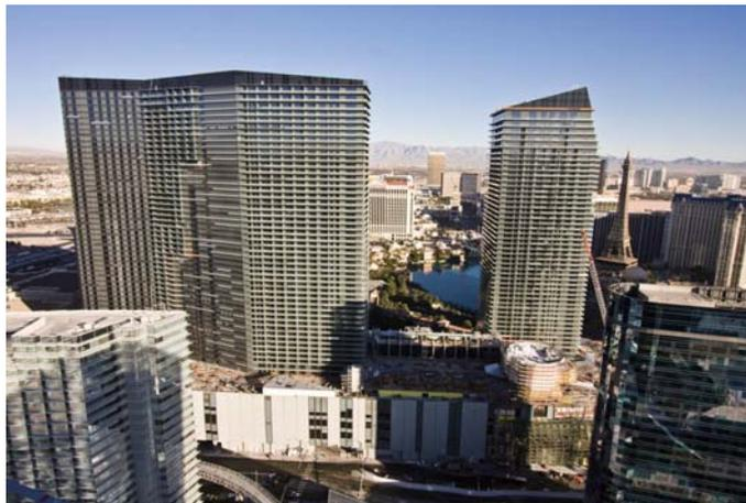
Cosmopolitan Resort Hotel & Casino位於美國拉斯維加斯。本公司透過其全資擁有的Far East Aluminium Works (U.S.) Corporation承接此項目。本公司於二零零六年對此項目開始施工，而項目預期於二零一零年初竣工。此項目所涉及的幕牆總面積為約130,000平方米。此項目涉及廣泛範圍的建築物外牆系統，包括幕牆、附設滑動門的窗牆、玻璃扶欄及隔牆。截至最後實際可行日期，此合同乃本公司最大的單一合同（以合同規模及合同金額計）。
