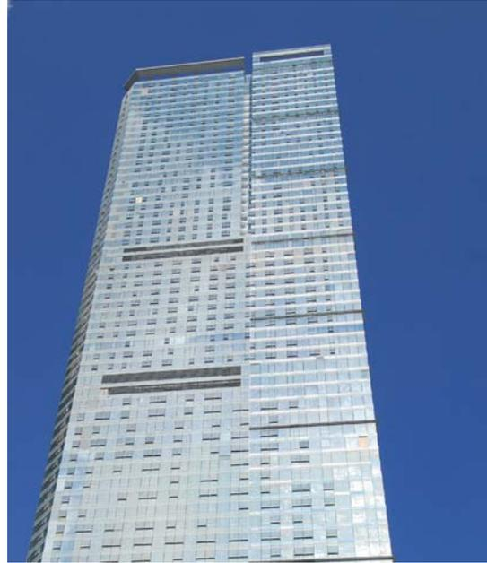
幕牆構成建築物的外部牆體，且一般由鋁材、玻璃、花崗岩及其他鍍層材料組成。幕牆一般由附加在建築物的板邊緣上的鋁框承托，而建築物的板邊緣一般指分隔建築物的外層水泥磚。在遵守當地建設當局規則及幕牆業主要守則及標準的同時，本公司根據客戶的技術規範及唯美要求按客戶要求訂製每個幕牆系統。本公司所有幕牆均須經過廣泛的測試，包括氣密及水密性測試、結構完整性測試、地震運動測試及熱性能測試。於本公司大部分項目中，幕牆面板在深圳生產設施預製好並運往項目工地及直接安裝到建築物上。
