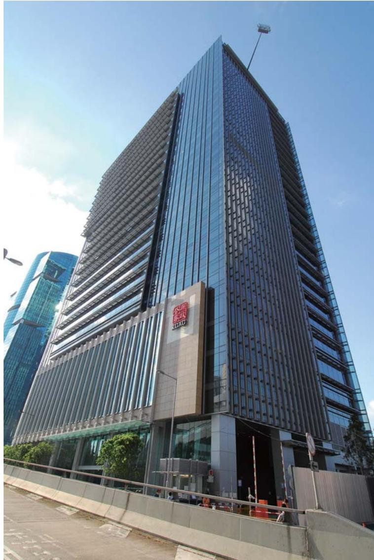
廉政公署總部大樓位於香港北角。本公司透過其全資擁有的遠東鋁質工程有限公司承接此項目。本公司於二零零五年對此項目開始施工，而項目已於二零零七年竣工。此項目所涉及的幕牆總面積為約35,000平方米。
