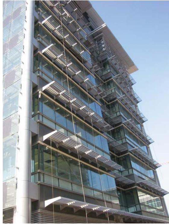
天棚用作防止建築物被陽光過度照射及透過減少建築物內所需的空氣調節量，有助提高建築物的節能性。
