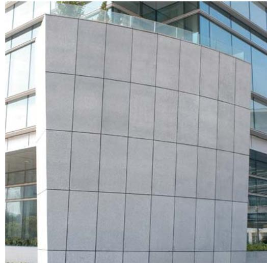
鋁質及不銹鋼鍍層一般用作覆蓋建築物外部的不可見部分。在一些項目中，用石頭替代金屬面板。
