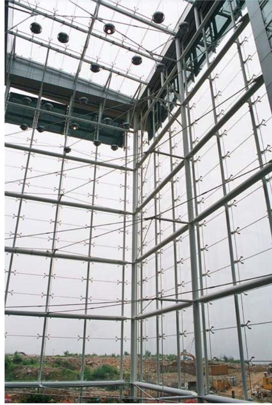
玻璃牆一般使用在層高較建築物其他樓層為高的建築物的裙樓、門廳或中庭。玻璃牆可由鋼構架、鋁構架及其他結構材料支撐，但慣常不會用作建築物各樓層的幕牆。店面一般由結構構架支撐的玻璃面板建造，以提升零售店面的吸引力與透明度。
