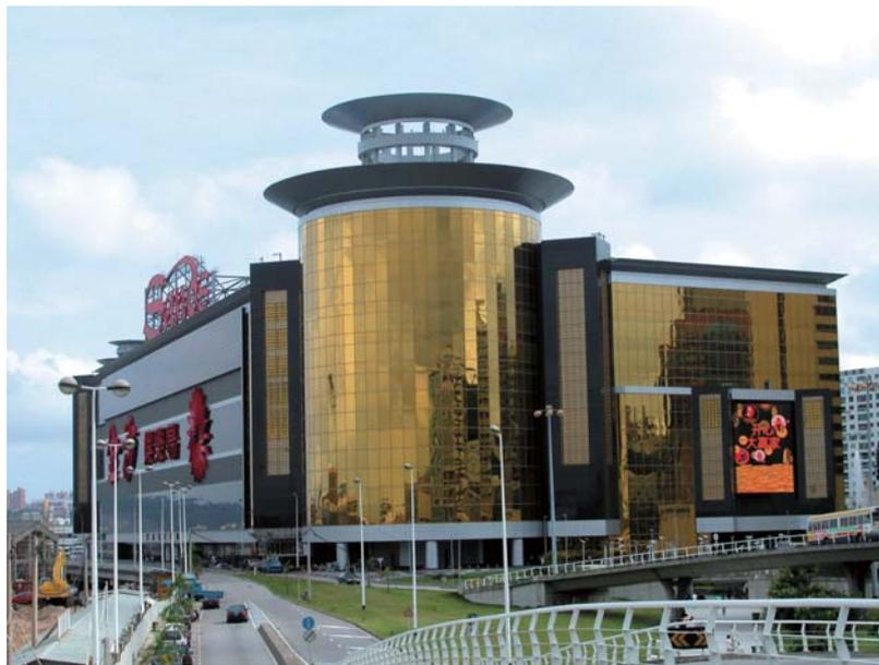
金沙賭場加建裙樓部分工程位於澳門。本公司透過其全資擁有的力進工程（遠鋁）澳門有限公司承接此項目。此項目乃自外國營運商獲發牌於澳門經營賭場以來澳門的首個外資賭場，而本公司獲委聘為金沙賭場加建裙樓部分工程施工。此項目特色為涉及安裝統一幕牆面板的成套幕牆系統。本公司於二零零三年對此項目開始施工，並於二零零四年完成一期項目及於二零零七年完成二期項目。此項目所涉及的幕牆總面積分別為約54,000平方米（一期）及20,000平方米（二期）。
