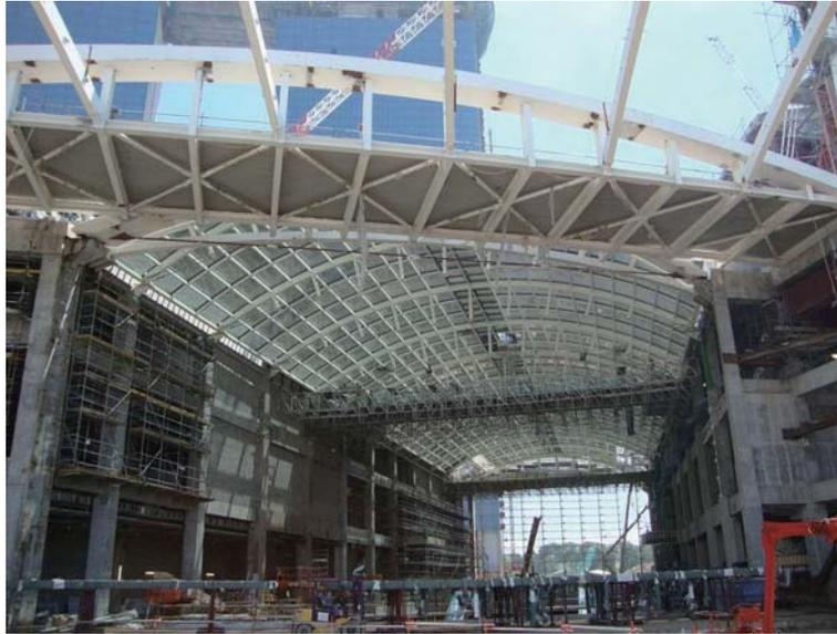
濱海灣金沙綜合度假勝地位於新加坡。本公司透過其全資擁有的遠東鋁質工程（新加坡）有限公司承接此項目。本公司於二零零八年對此項目開始施工，而該項目預期於二零一零年竣工。此項目所涉及的幕牆總面積為約9,000平方米。本公司參與安裝了觀光走廊的玻璃牆，以及旱冰場的天窗。此項目的工程範圍包括支撐裙樓內天窗及玻璃牆的電纜架構及為符合設計技術規範度身訂造玻璃牆架構。
