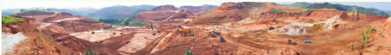
本公司位於廣東封開在建中的最大水泥生產基地部份 A portion of the Company's largest cement production plant under construction in Fengkai, Guangdong
