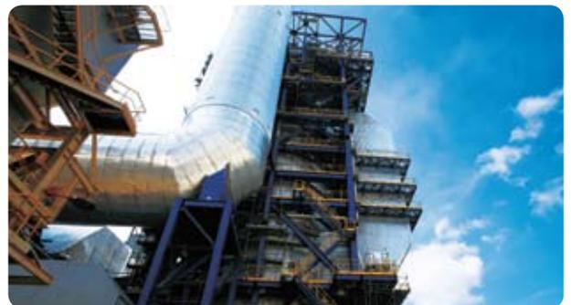
為五號燃煤機組加裝煙氣脫硫及低氮氧化物燃燒系統。
