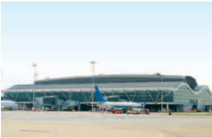
玻璃幕牆工程 — 香港國際機場 北衛星候機大樓
