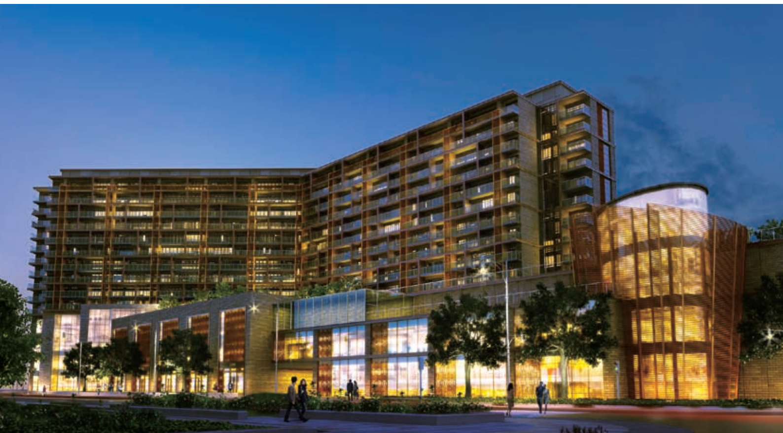
位於佛山嶺南天地D地塊的服務式公寓及購物中心
