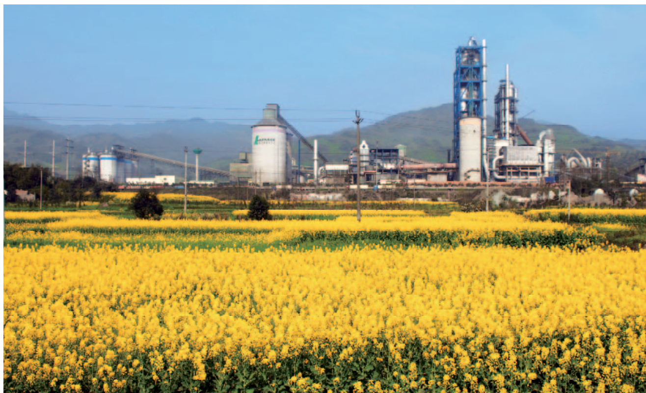
拉法基瑞安水泥位於四川都江堰的廠房
