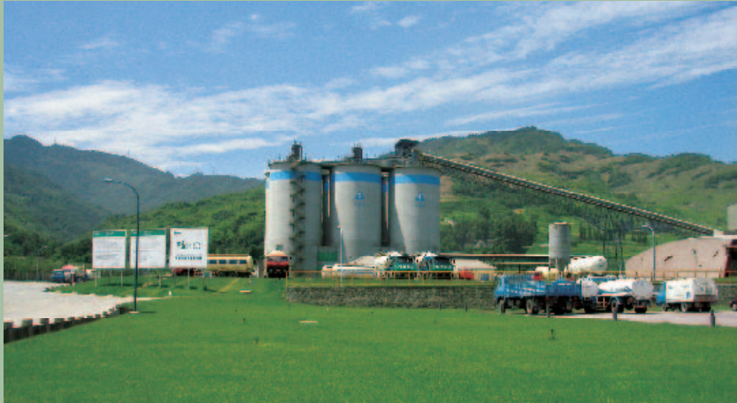
拉法基瑞安水泥的廠房採取潔淨及提升能源效益的生產方法
