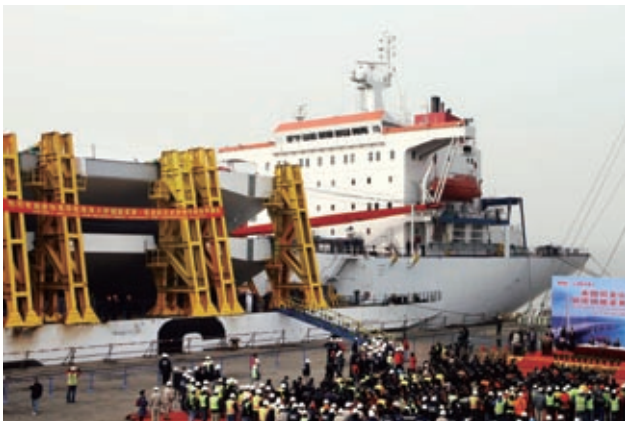
美國新海灣大橋首船鋼箱梁
