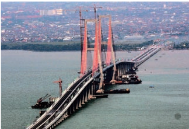
印尼泗水－馬都拉大橋，斜拉式跨海橋
