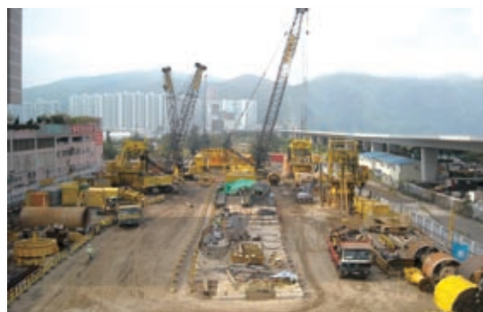
建聯集團旗下建築地基有限公司進行之地基打樁工程
