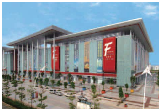
Phase II Trade Plaza Two 二期二號交易廣場
