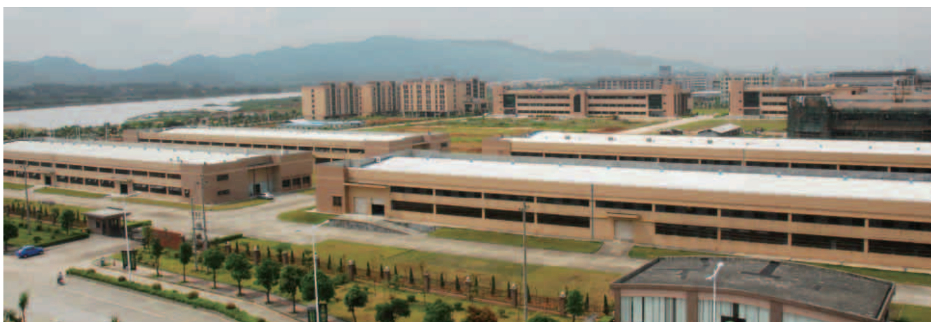
在河源市高新技術開發區裡的台和工業園
