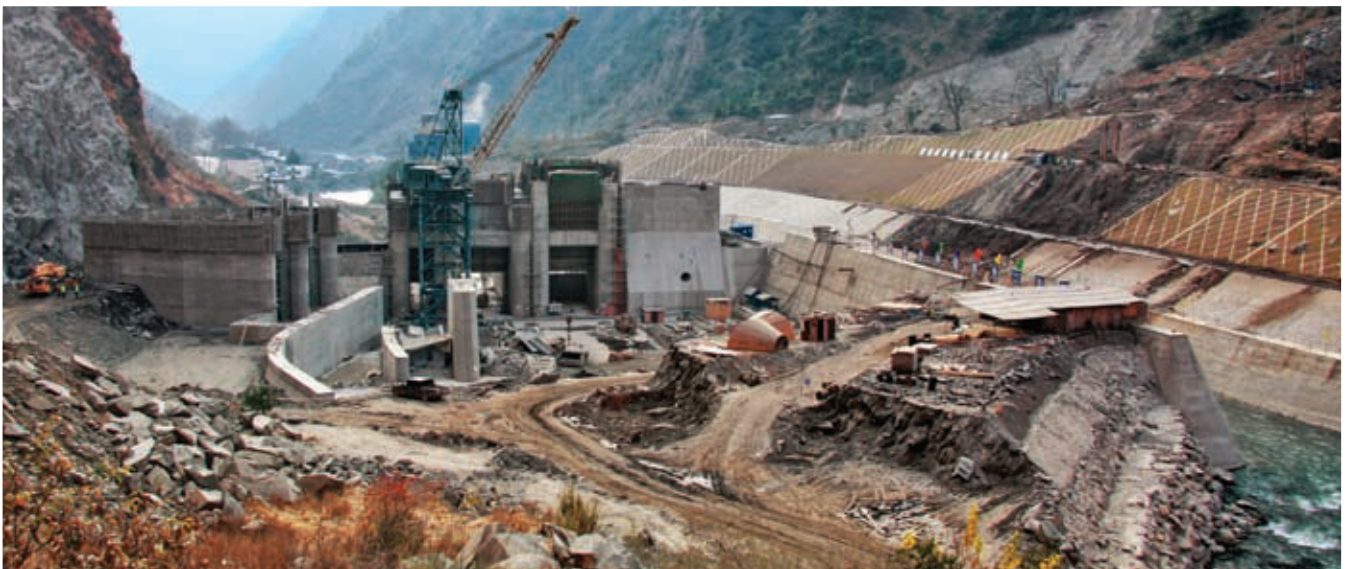
在江邊施工中的主壩
