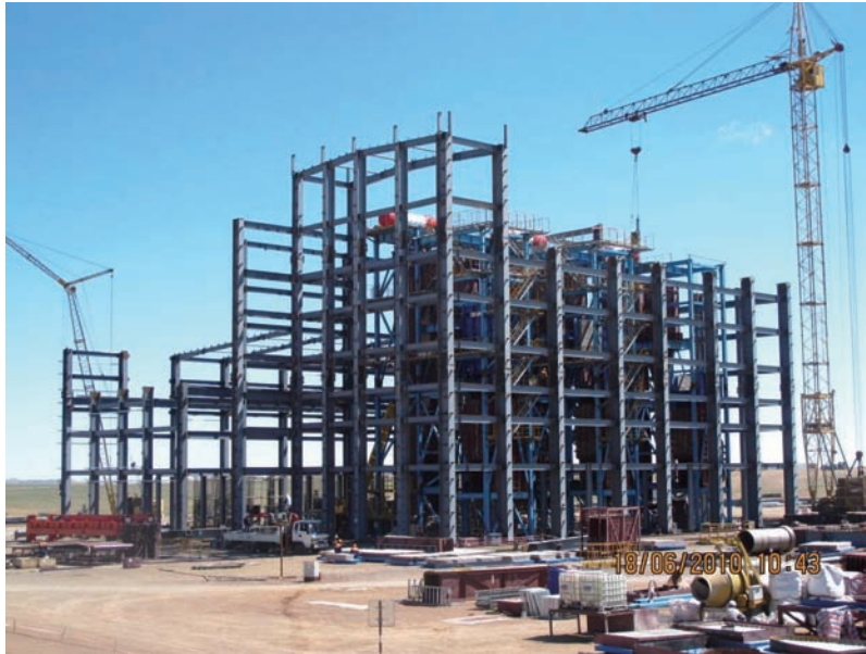
照片 4.3 興建發電廠
