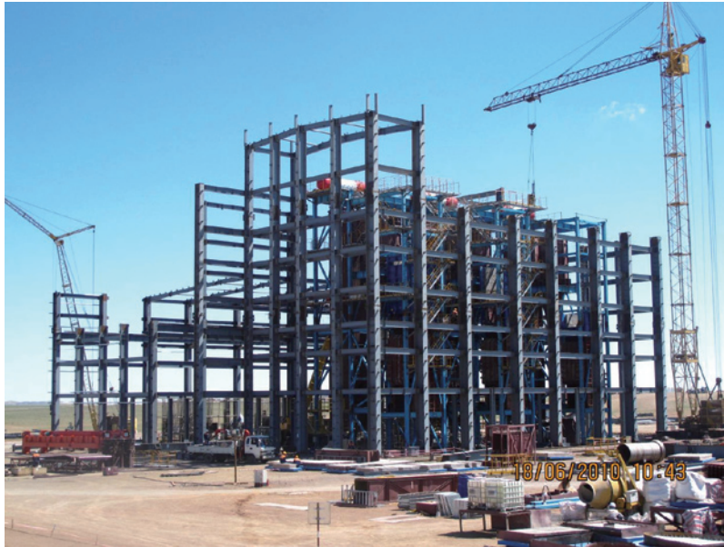
照片 4.3 興建發電廠
