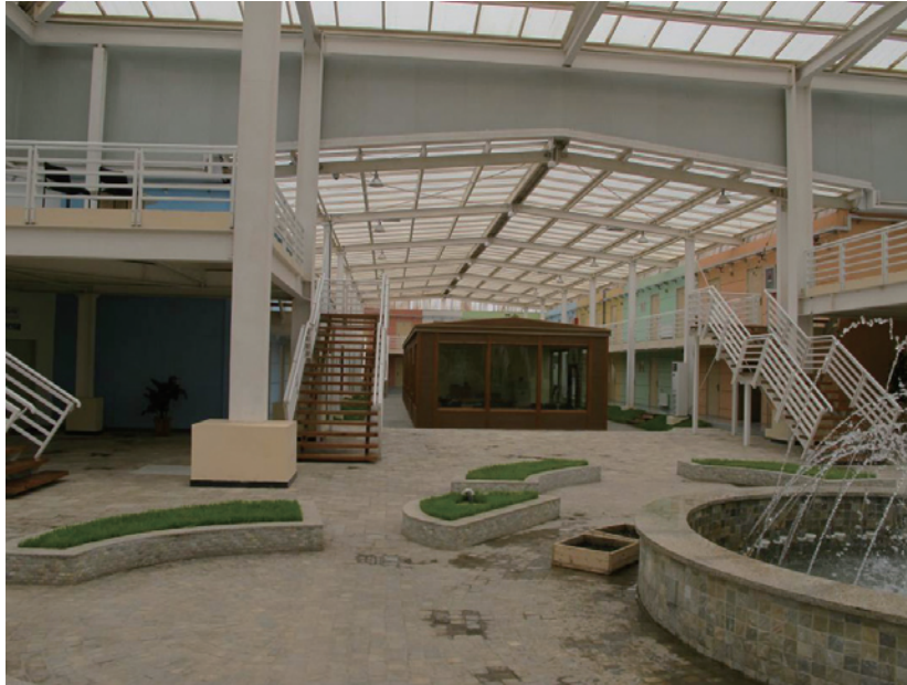
照片 4.2 礦山營地（內部）
