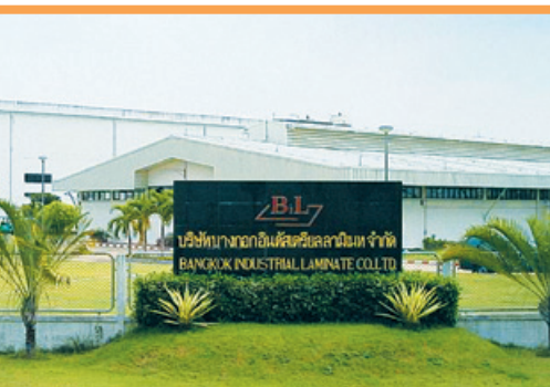
泰國銅箔製造廠房
