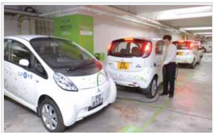
天盛停車場提供全港最大的電動車充電站
